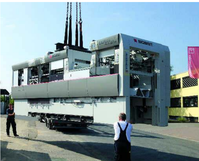
Die Expertcut 106 PER der neuesten Generation wurde Mitte 2013 bei Bretschneider angeliefert und installiert.
